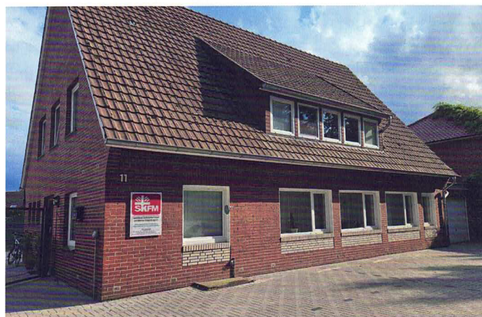
SKFM- Beratungsstelle, im hinteren Teil liegen die Appartements
